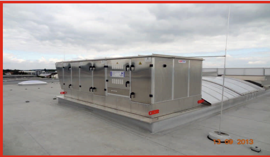
Lüftungssystem im Dachlichtband integriert
